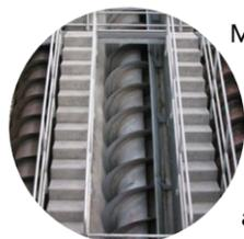
Mittels Zulaufhebwerk gelangt das Abwasser in das Rechengebäude, wo die Grobstoffe, Sande und Fette abgetrennt und anschließend entsorgt werden.
